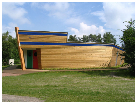
Sanitair gebouw De Potten Offingawier
