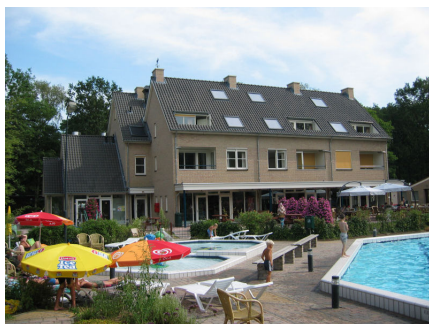
Centrumgebouw Bonte Vlucht Doorn
